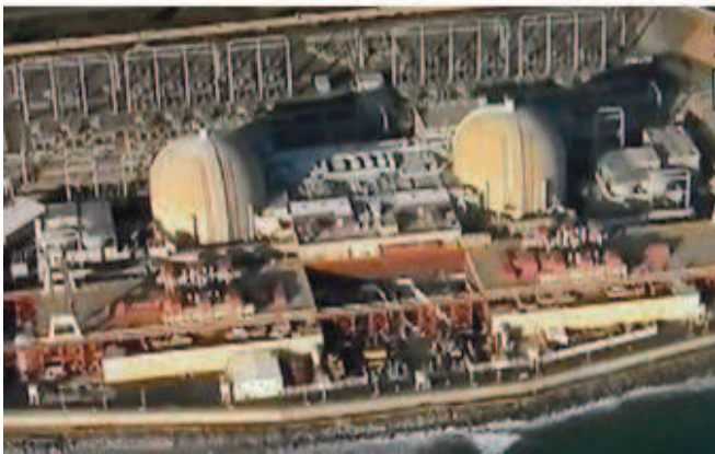
▲蒸気発生器の水漏れを起こしたアメリカの原発
