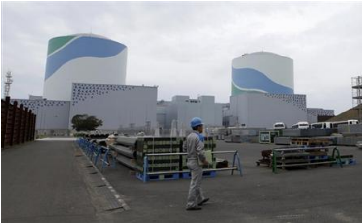
▲再稼働の準備が進む川内原発の構内
