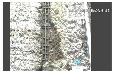
この部分は内側の土砂を取り除いて工事を進めるために、この施工不良が見つかったが、そのほかでも地中連続壁工法の防潮堤部では、すでにその基礎は土中であって、掘り起こして確認しないと分からないという。
