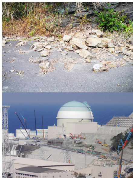
3号機周辺は工事だらけの伊方原発 (上下とも2015年10月20日撮影)
